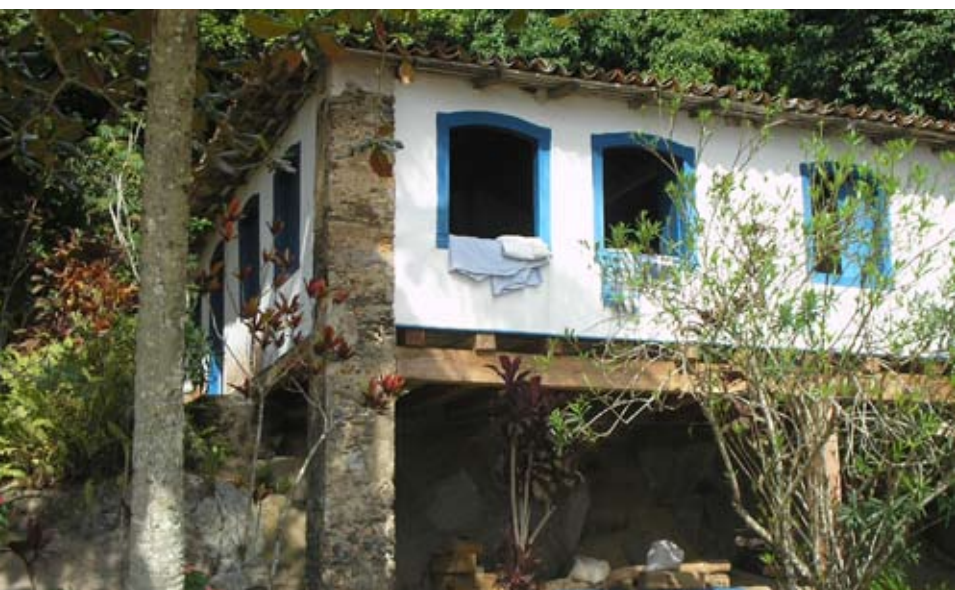
Photographie : Mariana Pirró. Plage de la Fome. 2008. Maison coloniale en torchis et piliers avec pierre.
