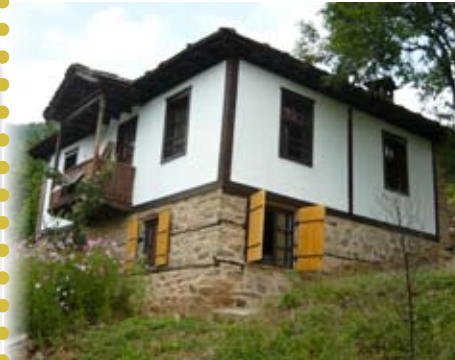
Restauration de la Ferme Rahovitza Architecte Varvara Valtchanova Photographie : Alain B. Mantchev
